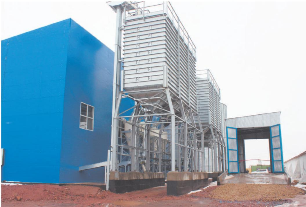
В Северо-Казахстанской области введено в эксплуатацию современное зернохранилище мощностью 6000 тонн и прием линия для приемки, предварительной очистки, хранения, сушки и отгрузки элитных семян зерновых культур.
