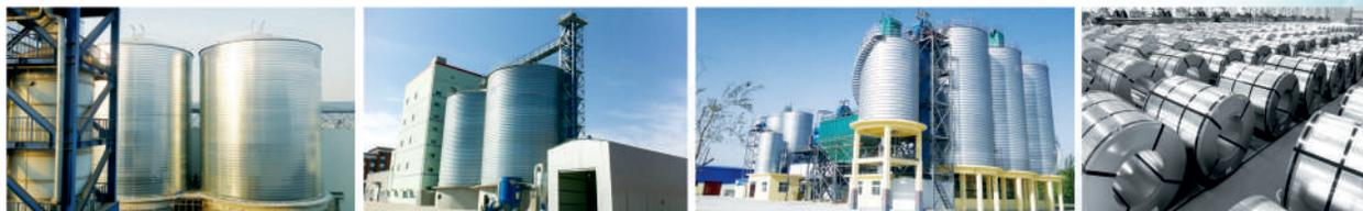
ООО "Сибэкструдмаш" предлагает оборудование для хранения сельскохозяйственной продукции. Силосы, выполненные по технологии спирального соединения, строятся из листов металла в виде непрерывной спирали, и отличаются долговечностью (срок службы составляет более 30 лет), хорошей герметичностью и водонепроницаемостью; они не требуют какого-либо техобслуживания и могут выдержать землетрясение до 7 баллов и ветер силой до 12 баллов.
