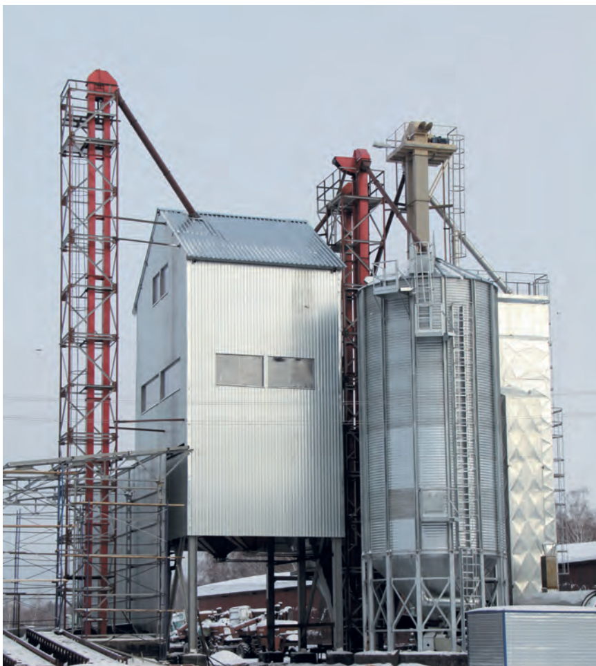
Зерноочистительно-сушильный комплекс больше похож на космодром
